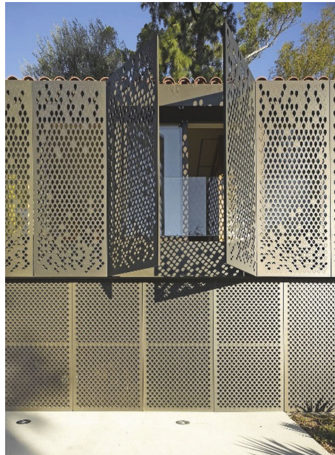
Die Fassade aus eloxierten Aluminiumtafeln öffnet sich mit riesigen Flügeln.
